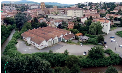
Site avant travaux
