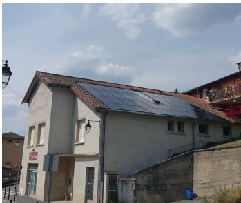
Mairie de Courzieu
